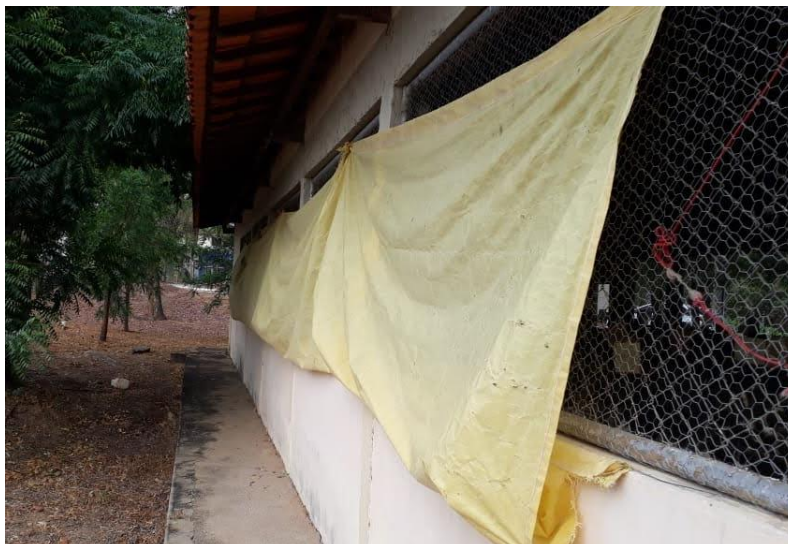
Figura 4. Mureta lateral do galpão com tela e lona
